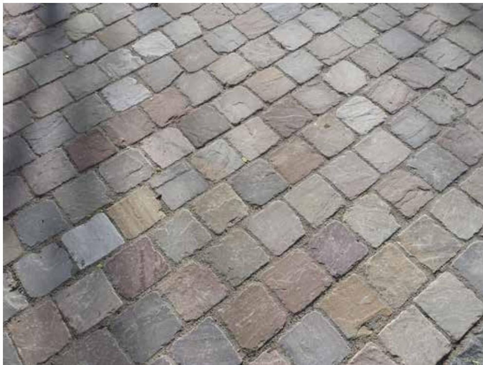
Pavage grès - centre-bourg
