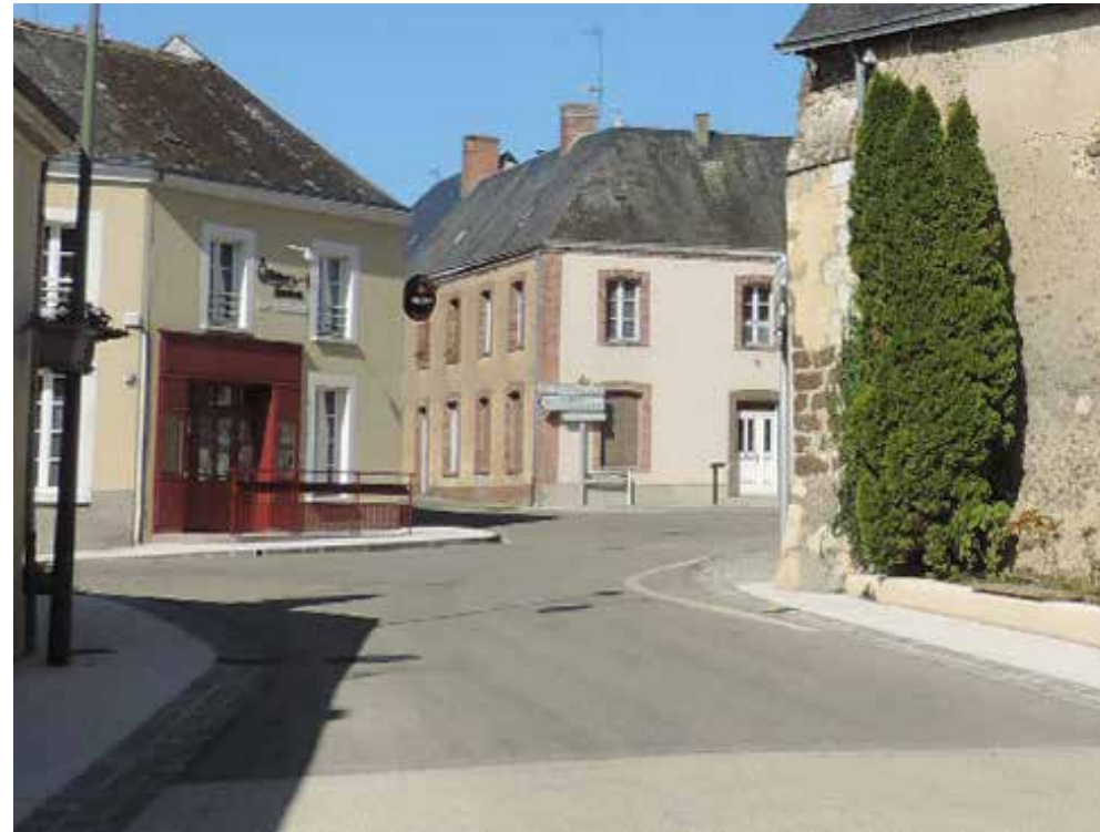
Enrobé grenailé (espace en voirie partagée)
