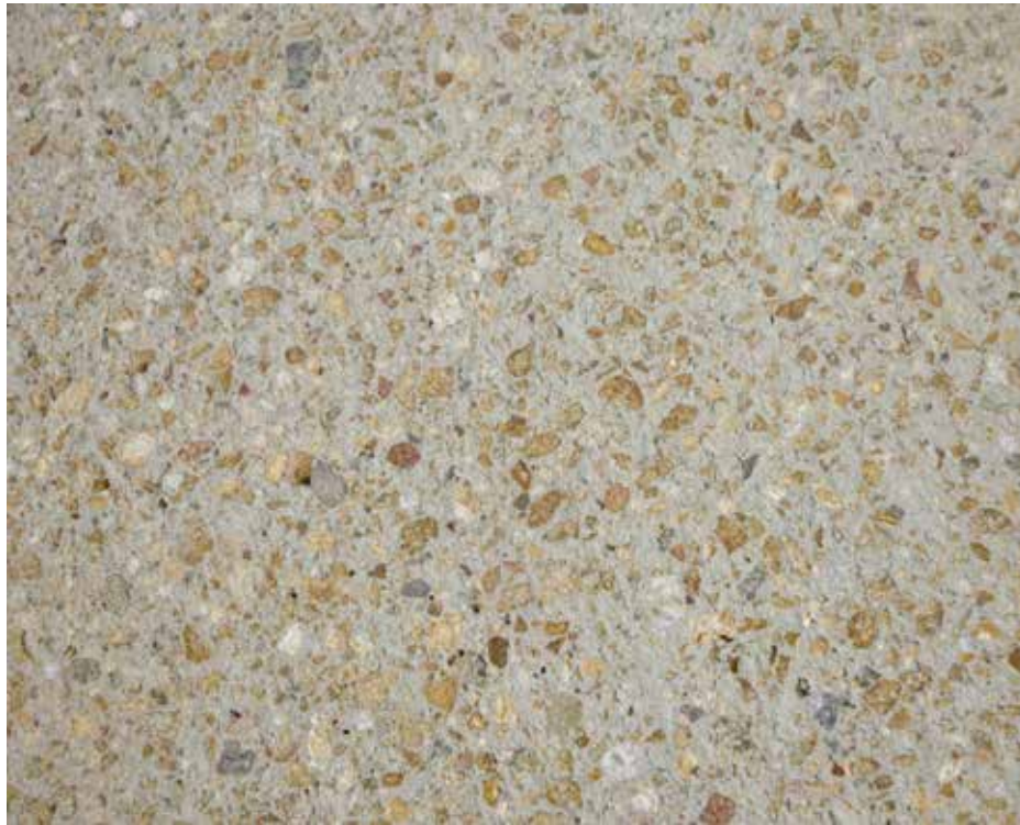
Béton désactivé - trottoir
